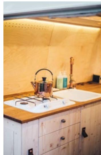
Die Holzoberflächen werden geschliffen und geölt. Besonderheit sind die Lüftungsbohrungen in der Wandverkleidung. Sie sorgen für einen guten Feuchtigkeitsaustausch.
